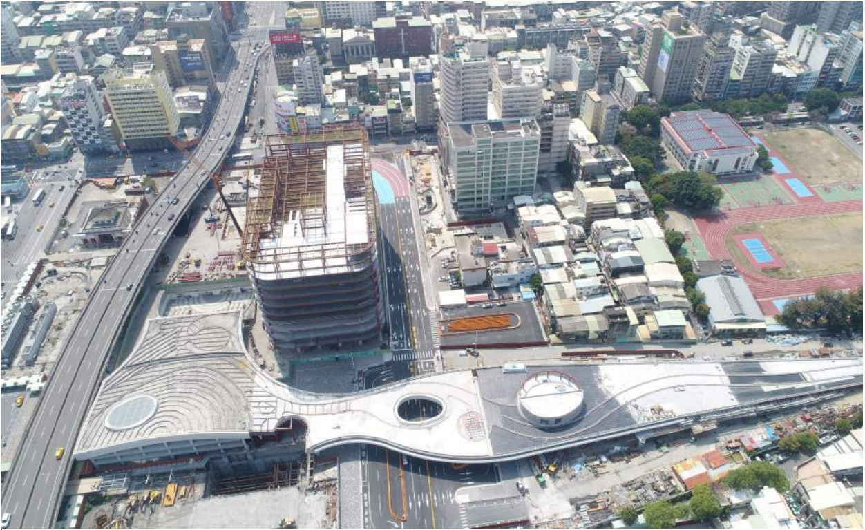
今年2月27日，連結北高雄和南高雄的中博高架橋，正式啟動拆除工程。
