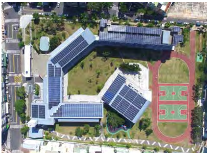
教育設施類建築：樂群國民小學（82 kWp）
