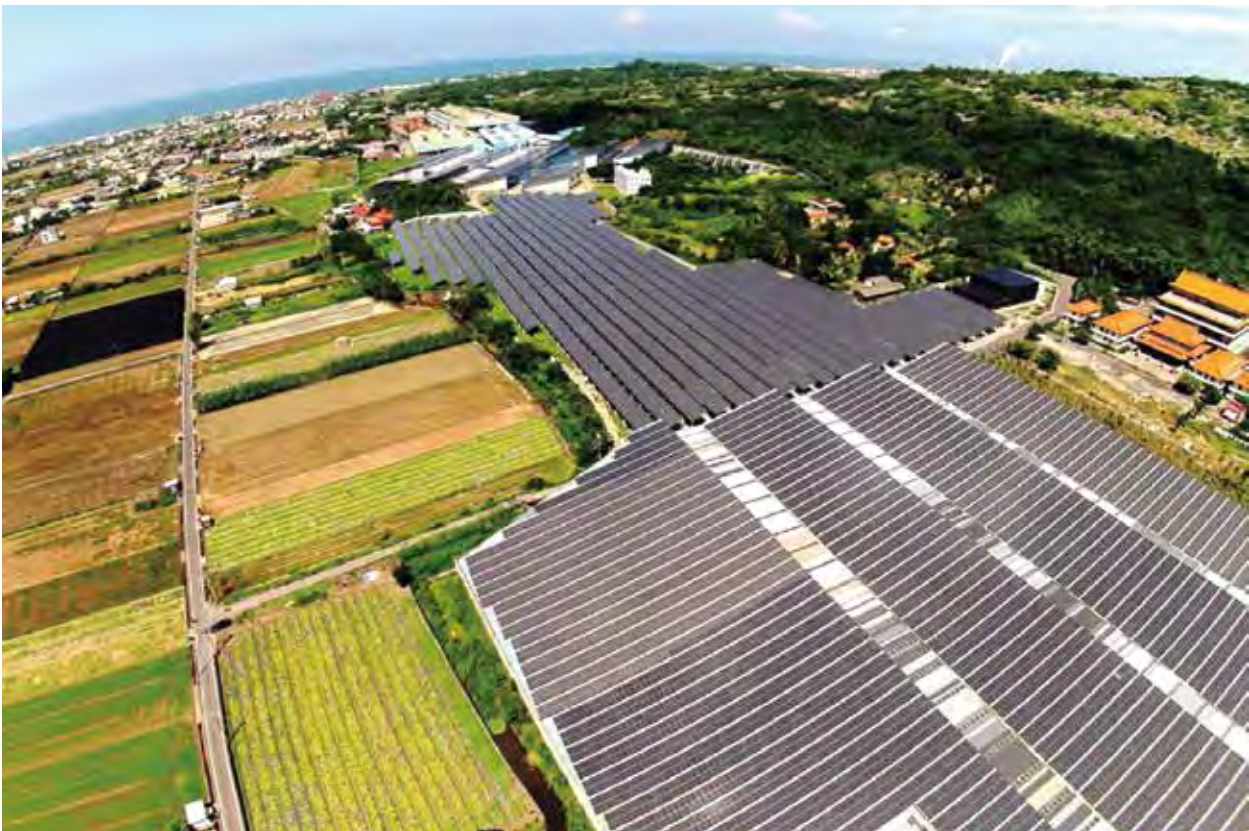
廠房設施類建築：壹東實業股份有限公司（14,962.38 kWp）
