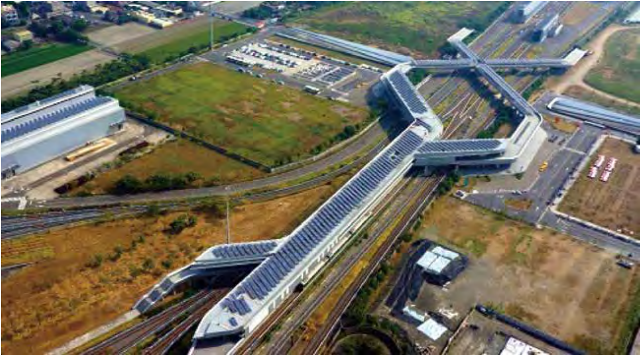
交通設施類建築：高雄捷運_大寮捷運站（2106.07 kWp）
